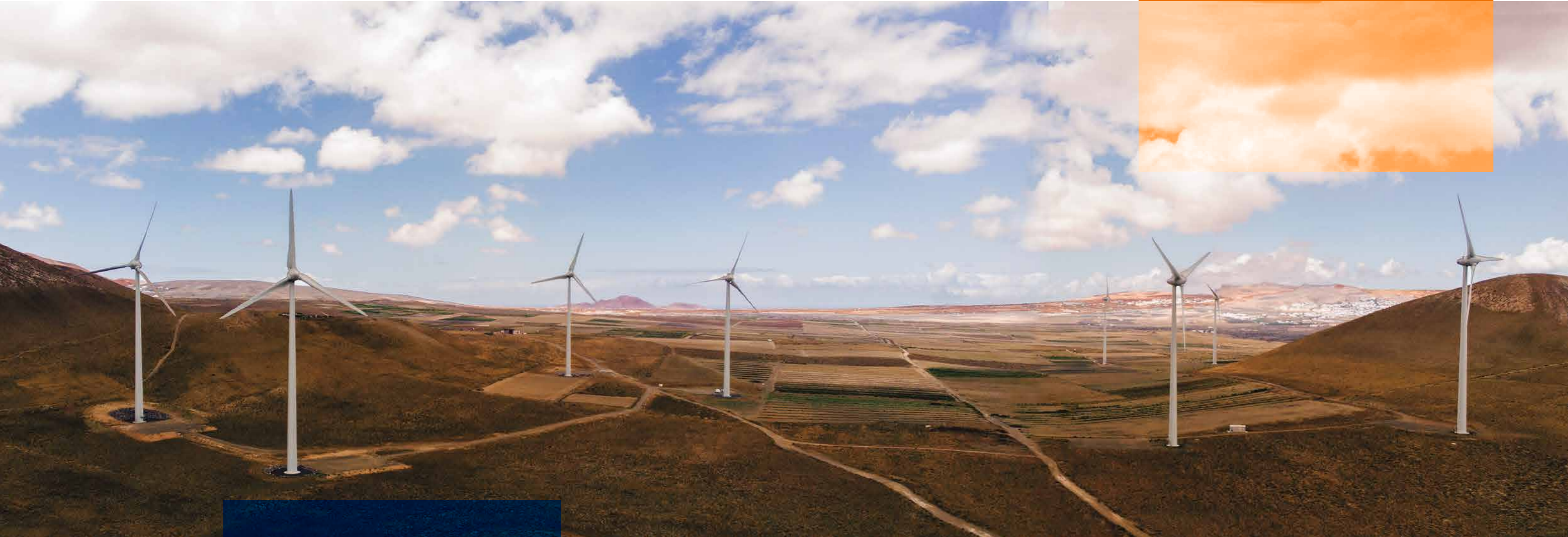
Energización parque eólico Arrecife en Gáldar, Gran Canaria (España)
