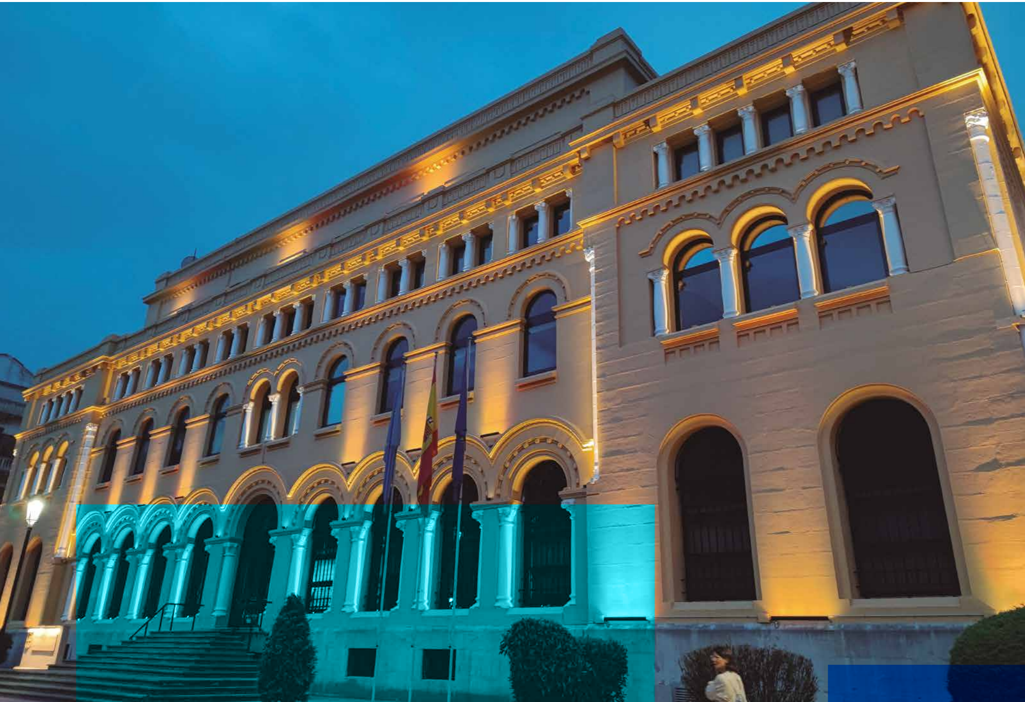
Rehabilitación de la fachada del edificio Presidencia en Asturias (España)
