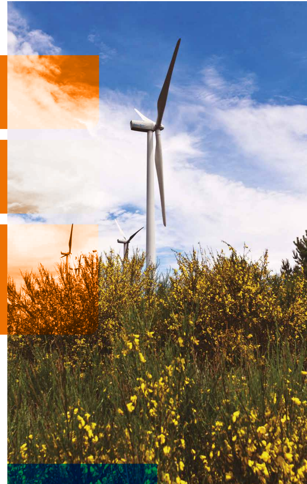
Parque eólico Faro Farelo en Lugo (España). Enerfín
