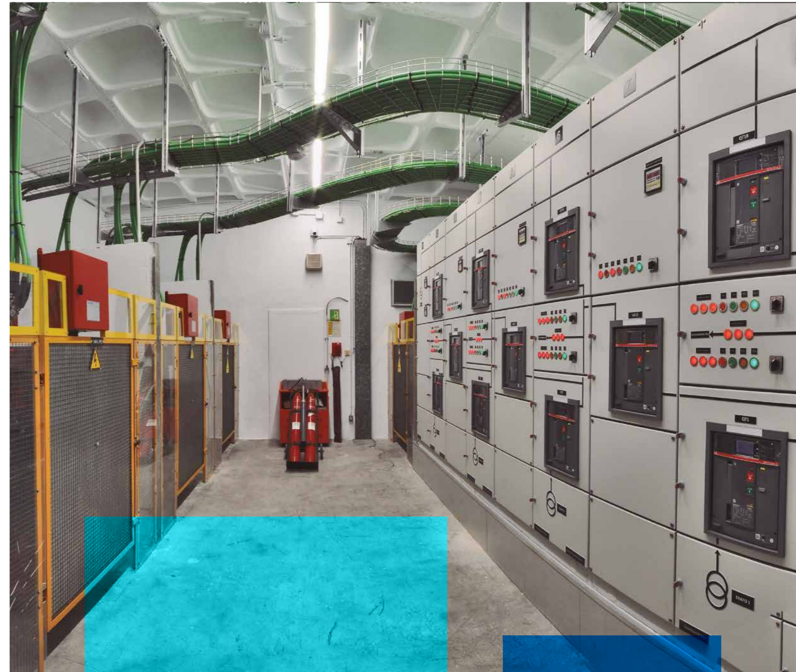
Instalaciones para TV3 Barcelona (España)
