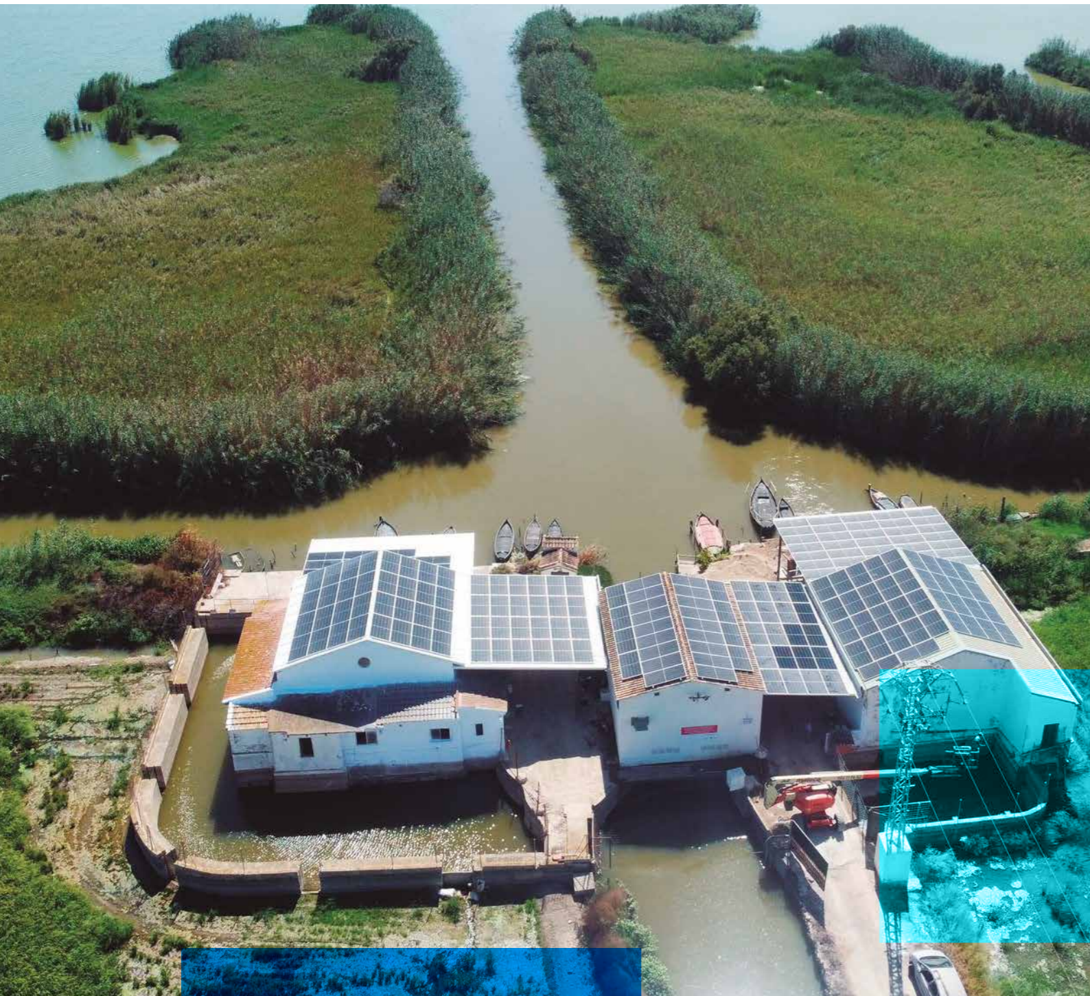
Primera instalación fotovoltaica integrada y actuaciones hidráulicas en el Parque Natural de la Albufera en Valencia (España)
