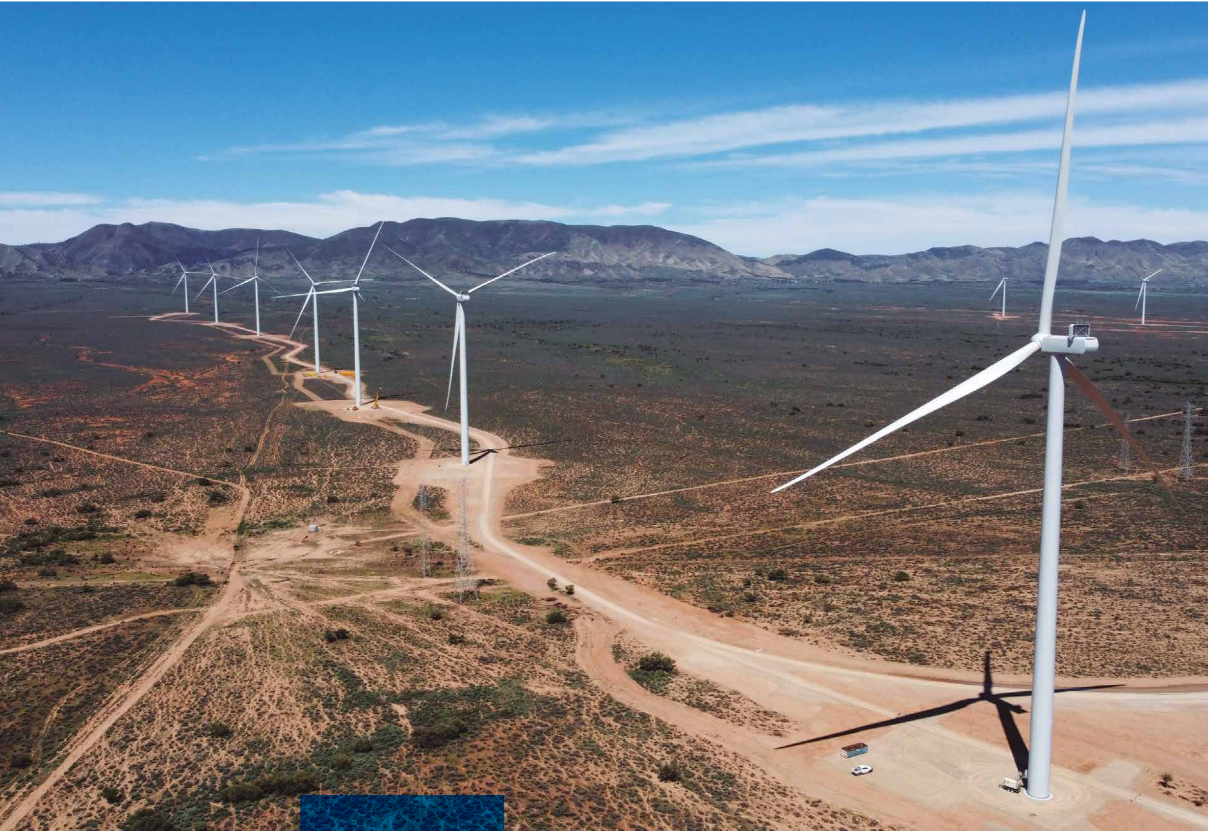
Parque eólico Goyder South (Australia)
