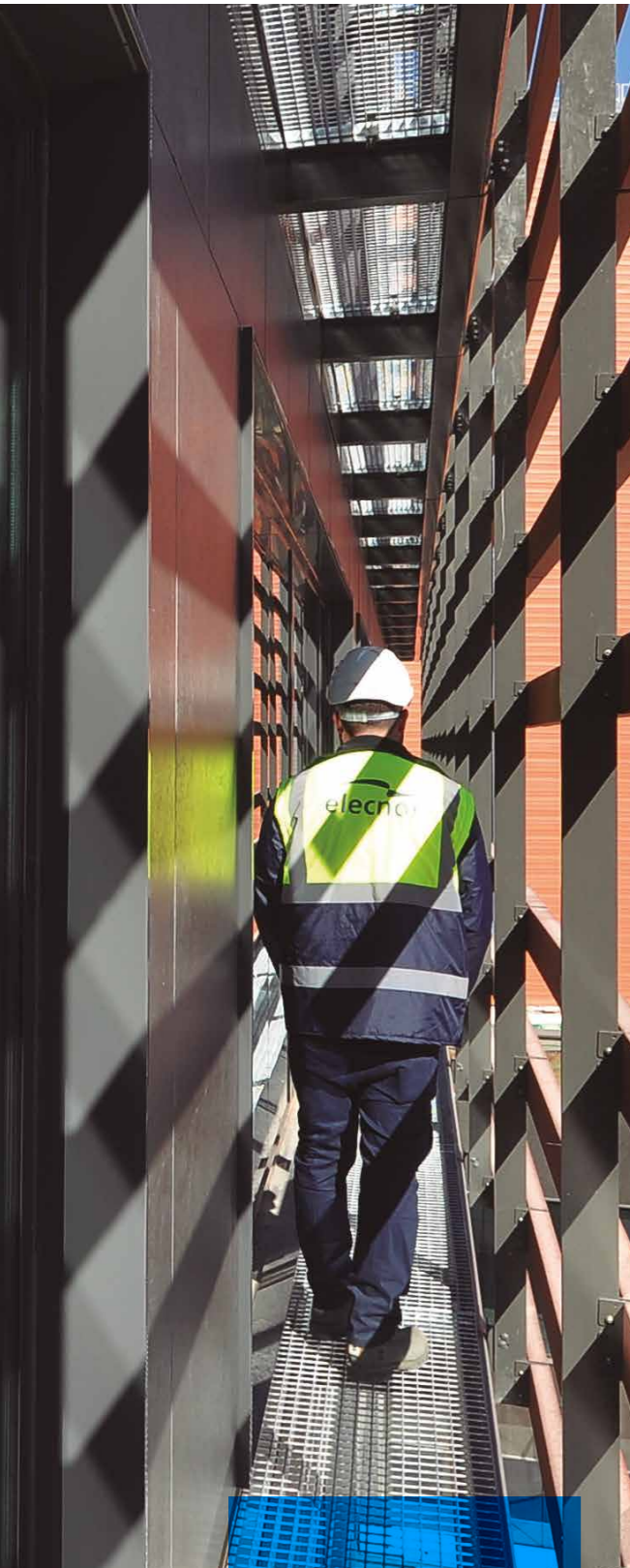
Construcción de edificio de oficinas Step-Up en Barcelona (España)
