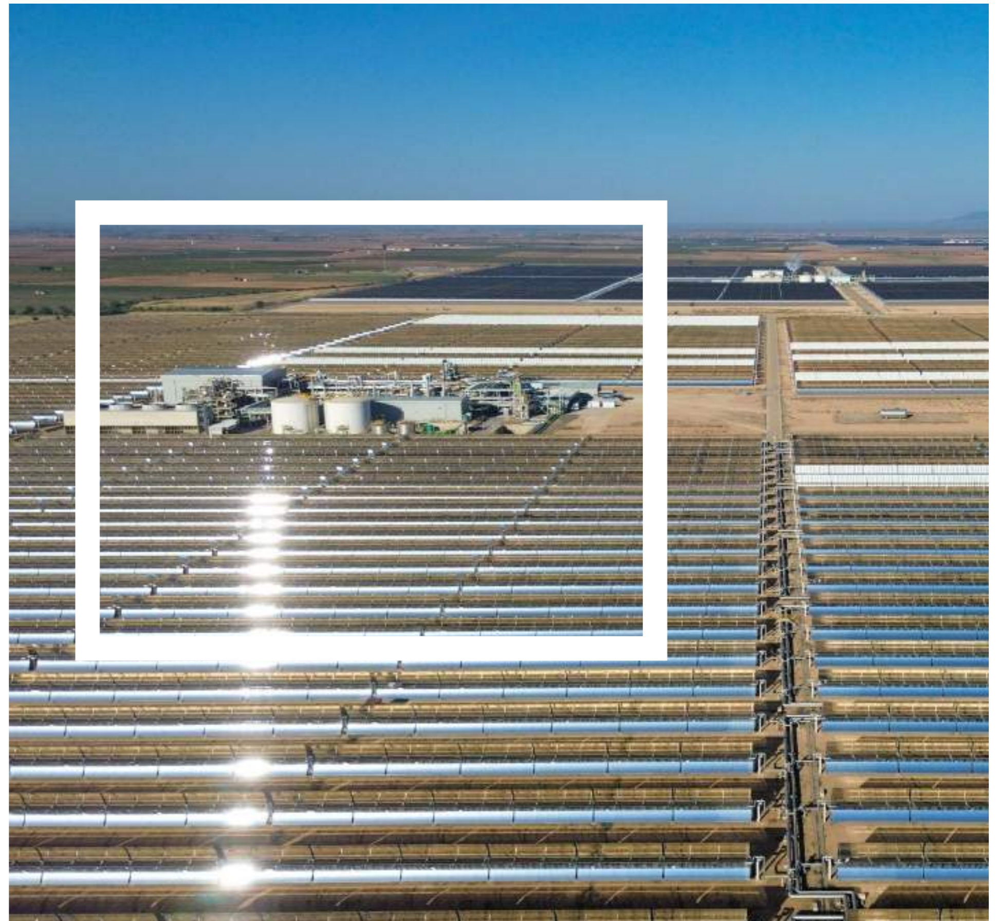
Aste 1A solar thermal power plant in Ciudad Real (Spain)
