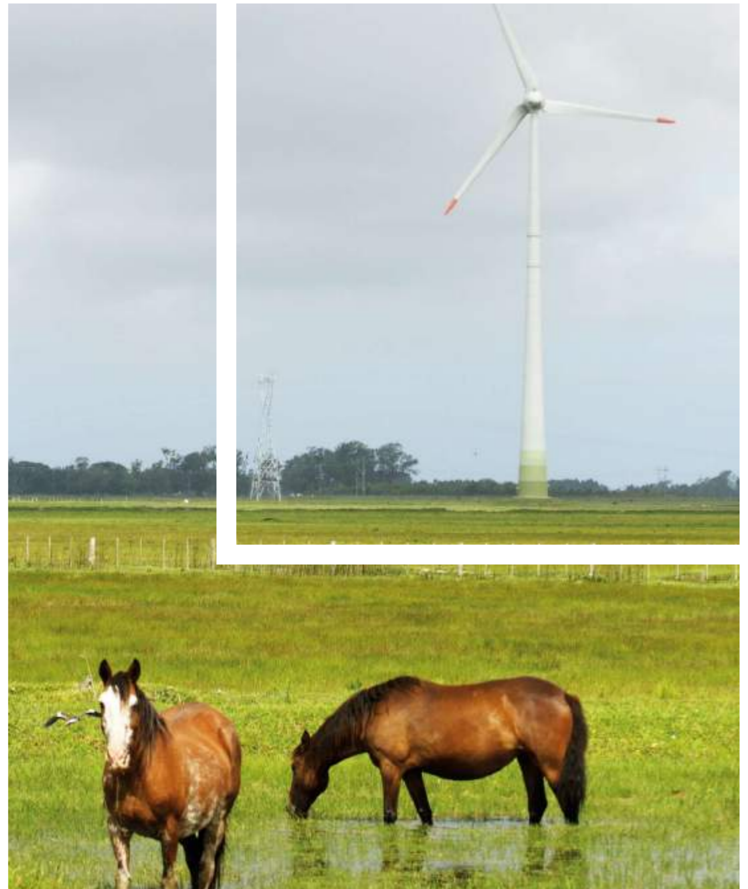
Osório wind farm complex (Brazil). Enerfín
