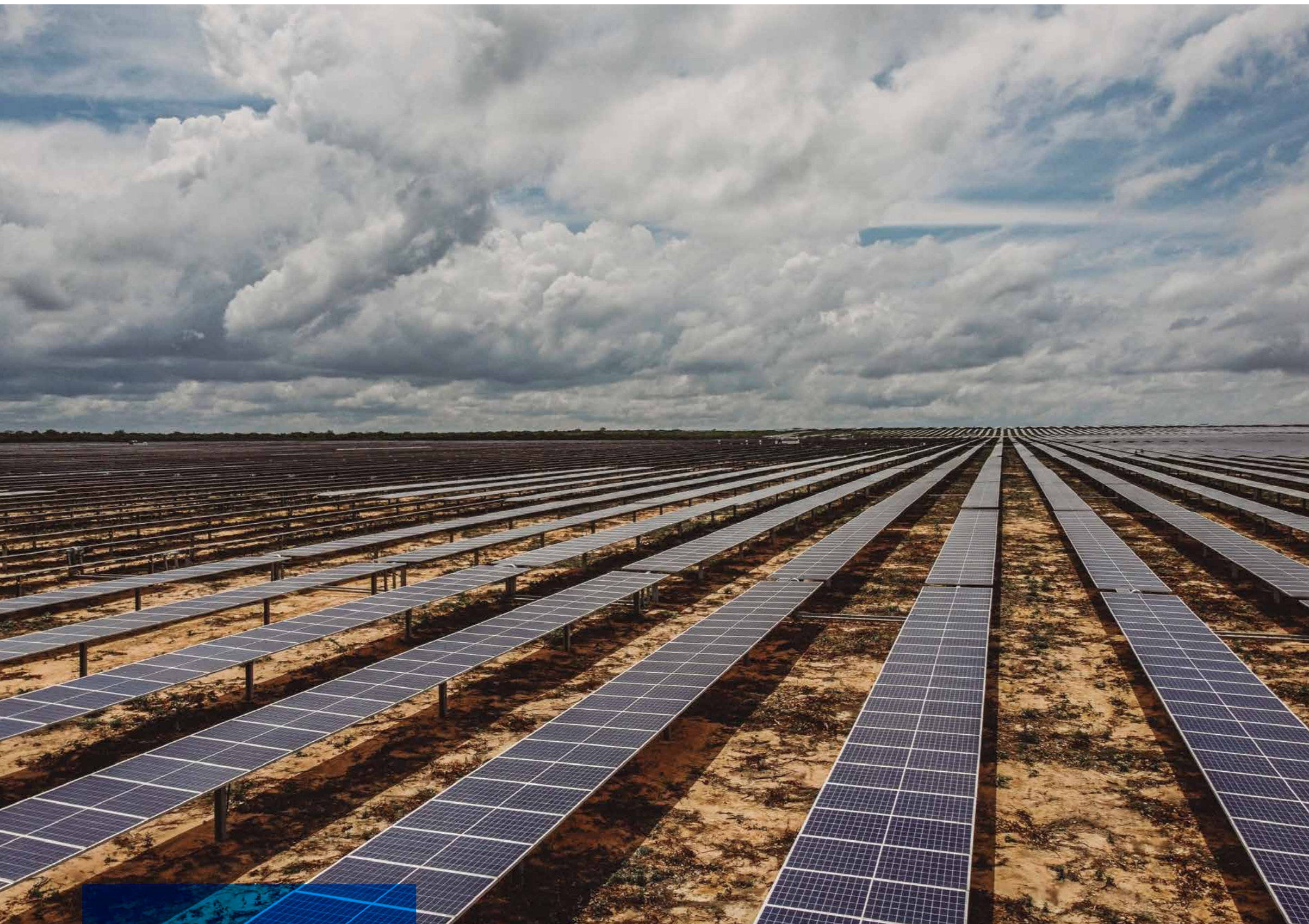
Estação solar fotovoltaica de São João do Piauí (Brasil). Celeo
