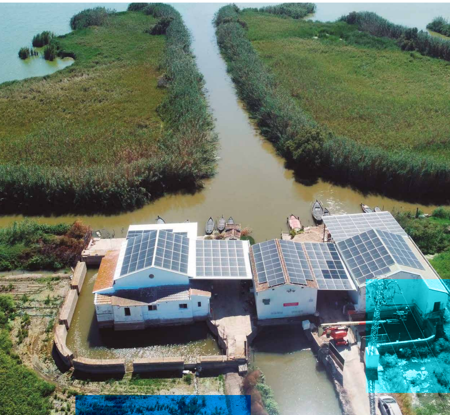
Primeira instalação fotovoltaica integrada e ações hidráulicas no Parque Natural de la Albufera, em Valência (Espanha)
