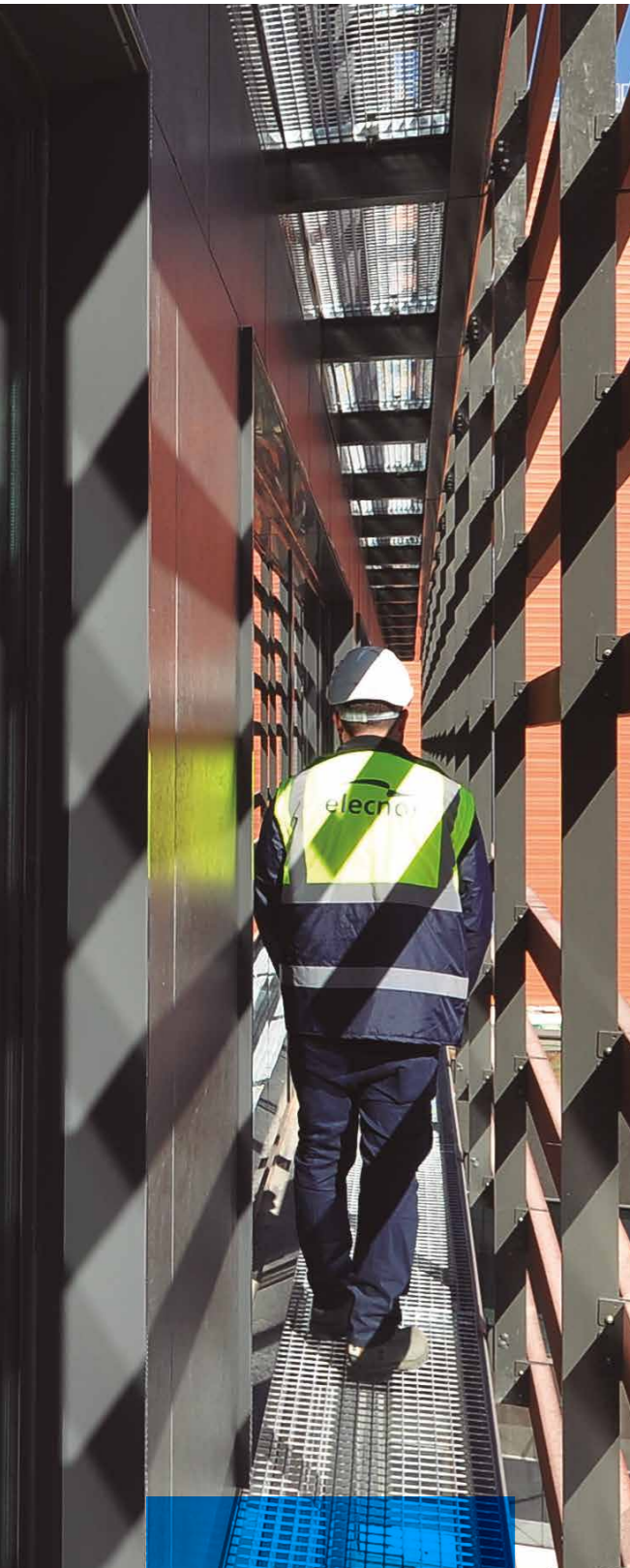
Construção do edifício de escritórios Step-Up em Barcelona (Espanha)
