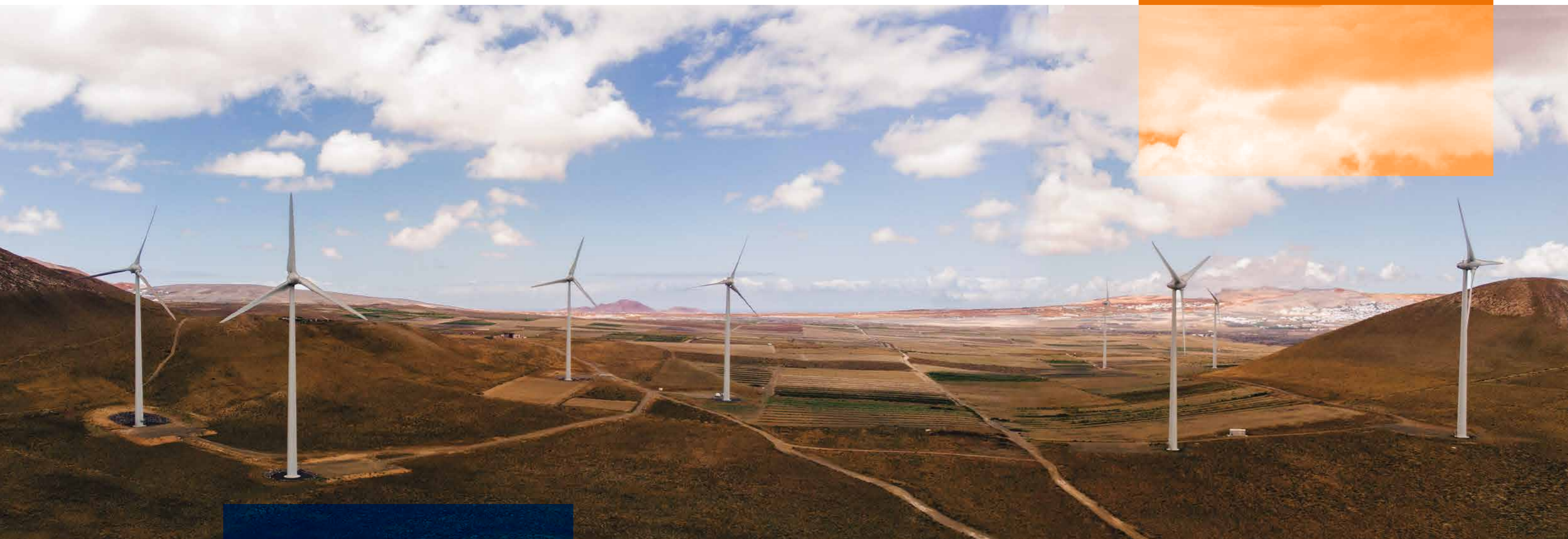
Energização do parque eólico Arrecife em Gáldar, Grã Canária (Espanha)
