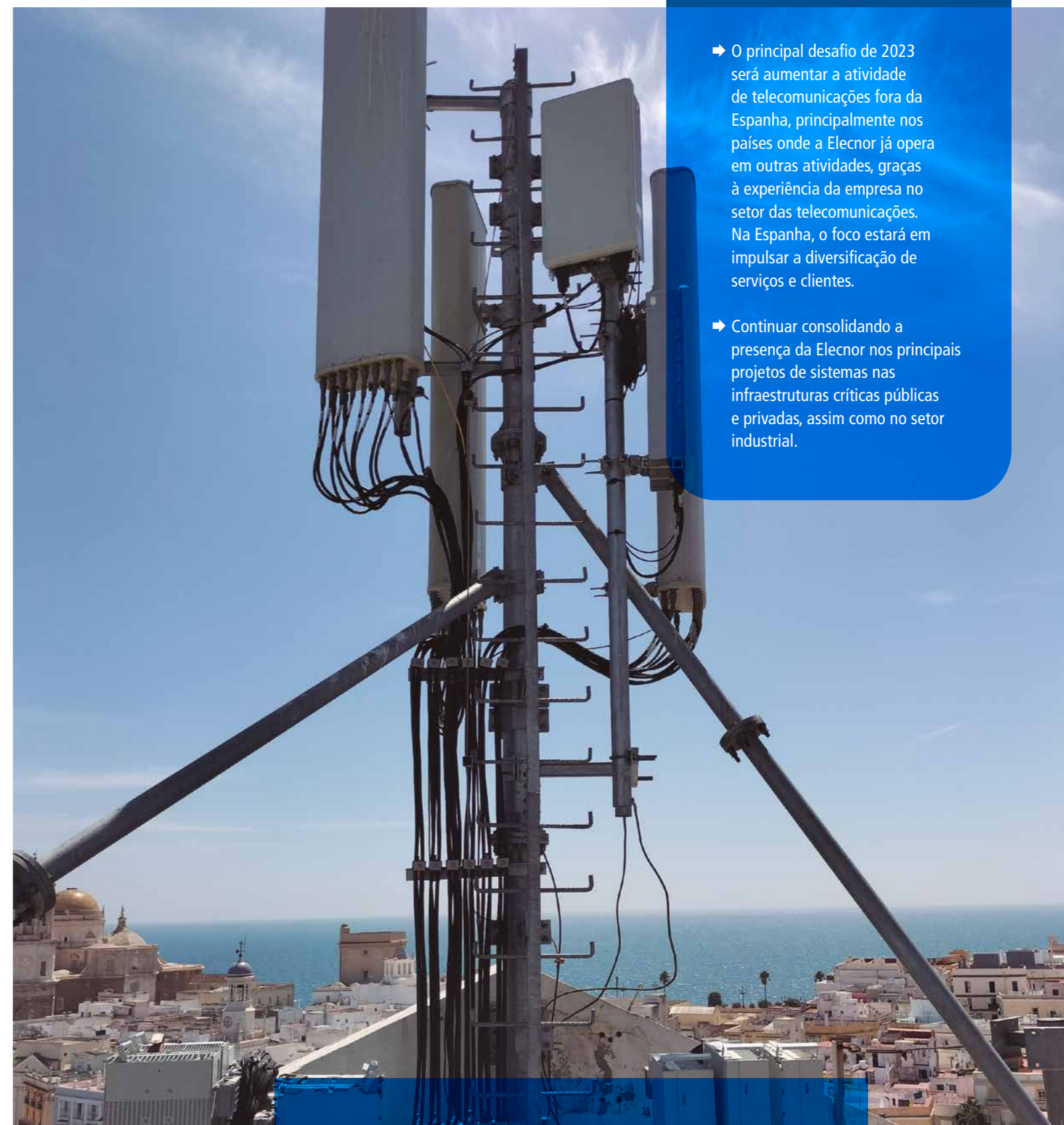
Instalação e integração de equipamentos Huawei para constituição de rede móvel (Espanha)
