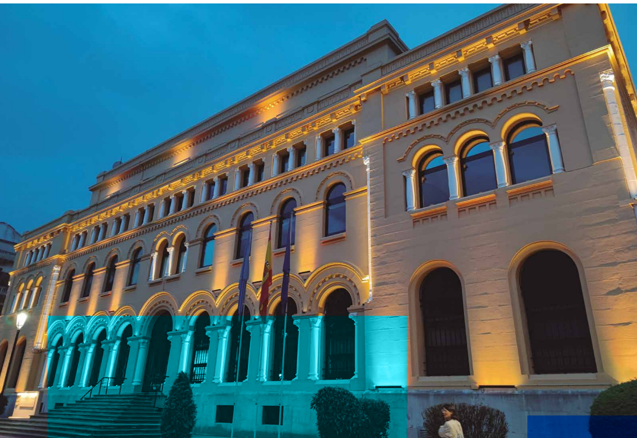
Reabilitação da fachada do edifício Presidência, em Astúrias (Espanha)
