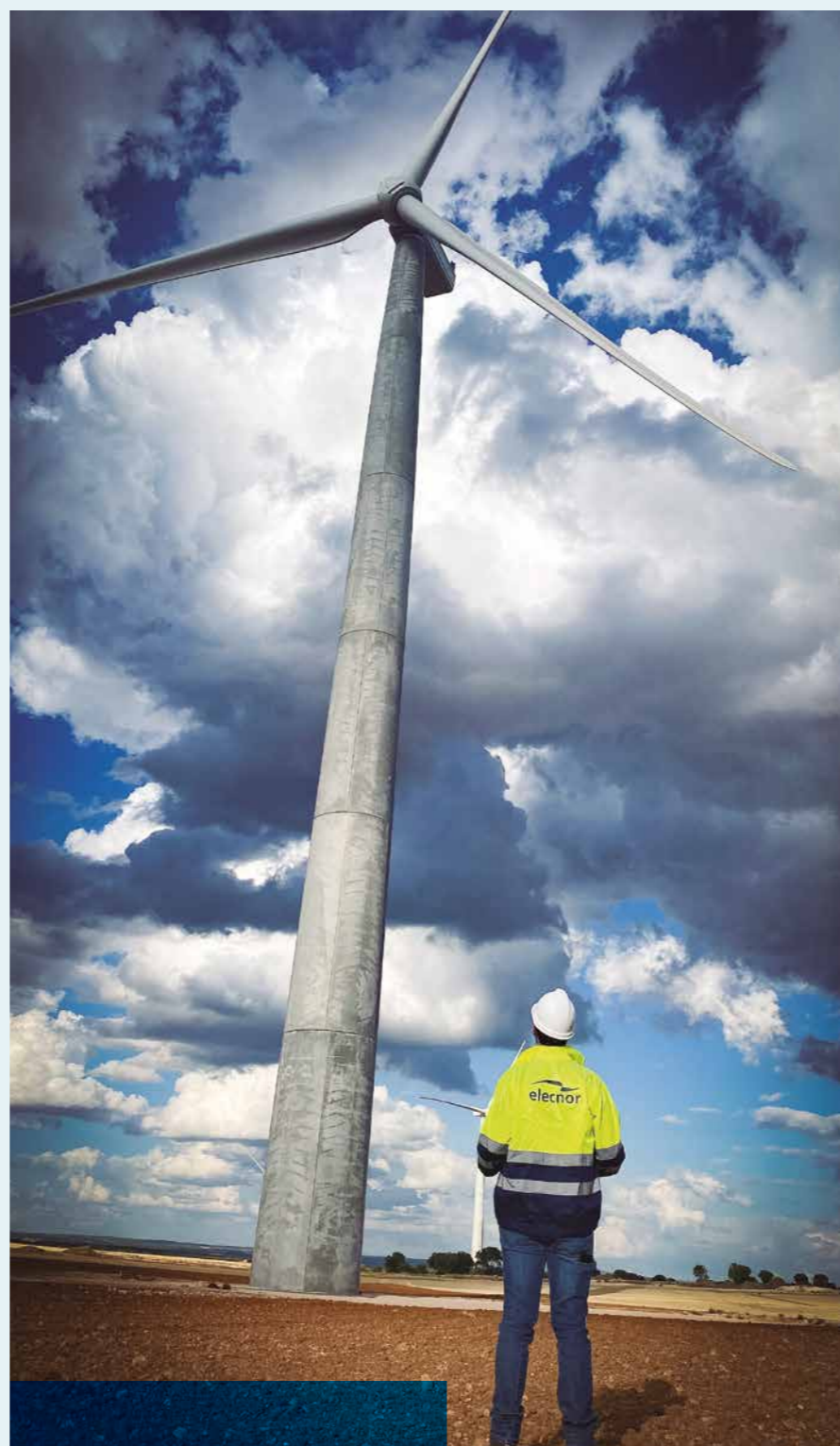
Parque eólico Gecama, em Cuenca (Espanha)
