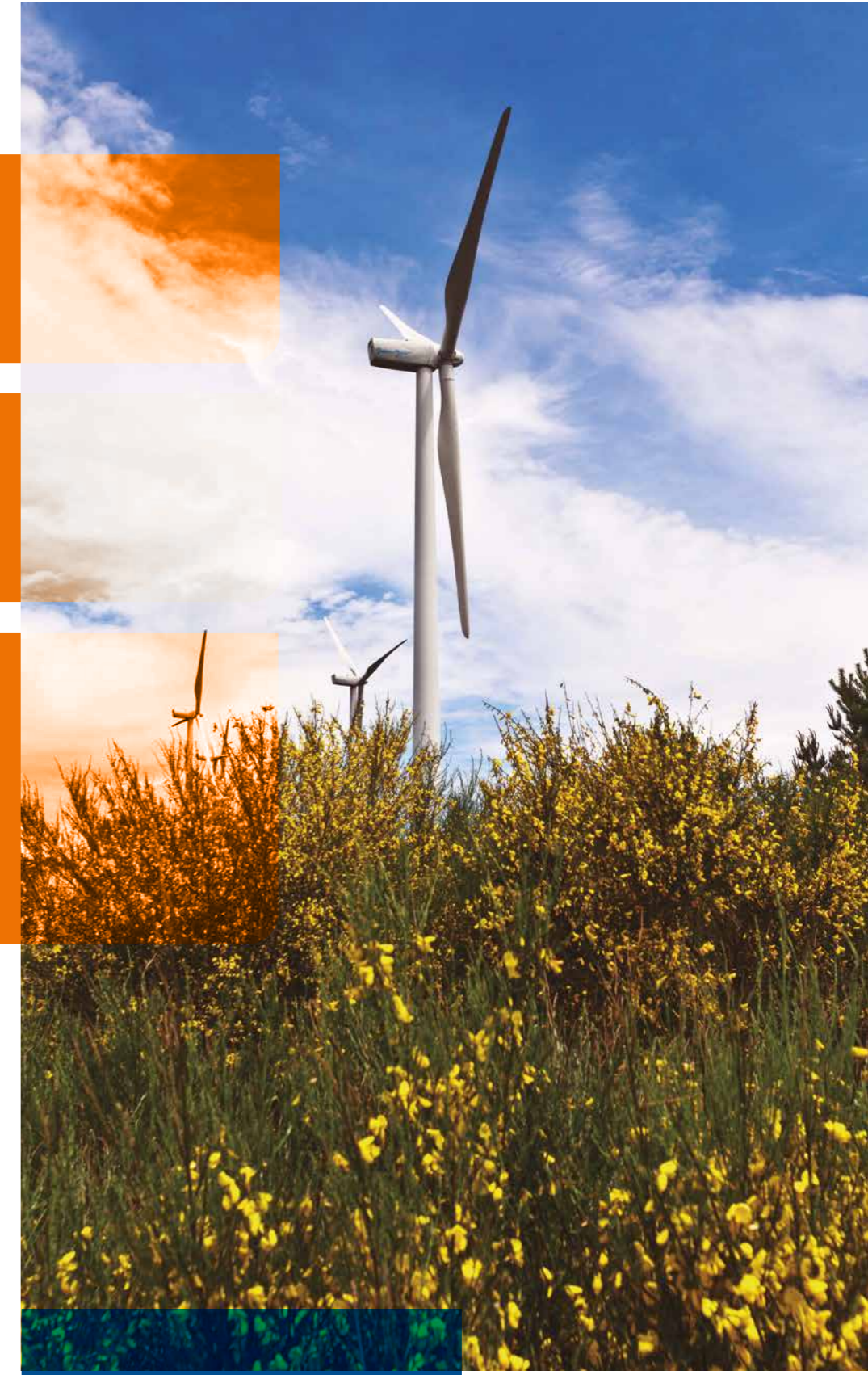
Parque eólico Faro Farelo, em Lugo (Espanha). Enerfín
