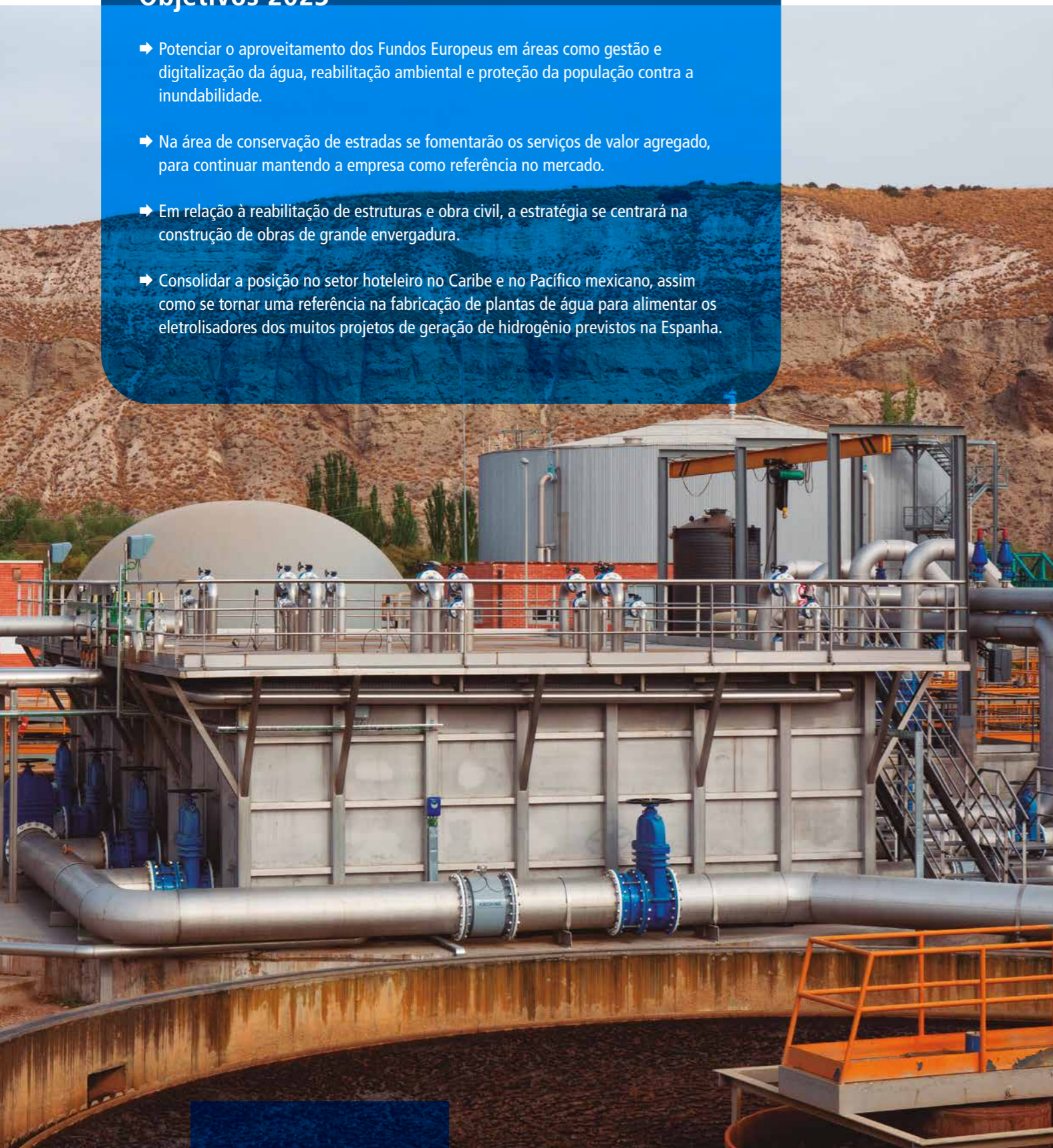
EDAR La Poveda em Madri (Espanha)
