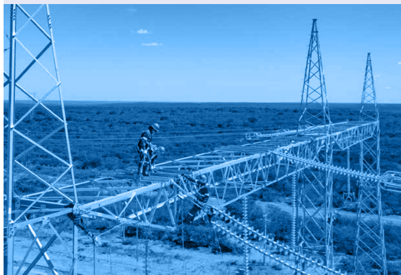
Subestação em planta solar fotovoltaica São João de Piauí (Brasil). Celeo
